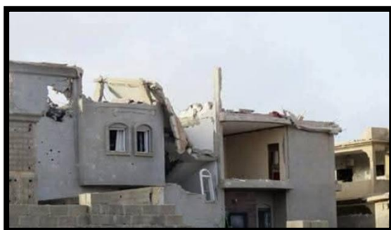
شكل (2): انهيارات جزئية وكاملة لمباني سكنية متعددة الطوابق
